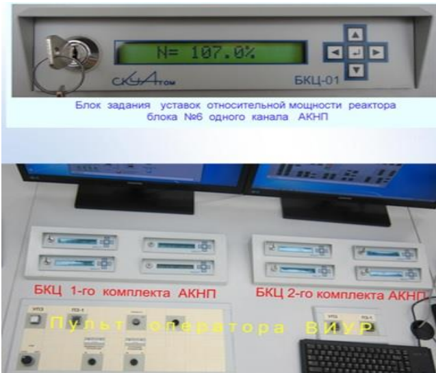
Рисунок 5.2.4 – Блок задания уставок (БКЦ-01) и его расположение на пульте ВКУР
