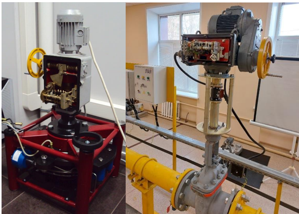
а б Рисунок 1 – Базовые испытания привода на стендах
