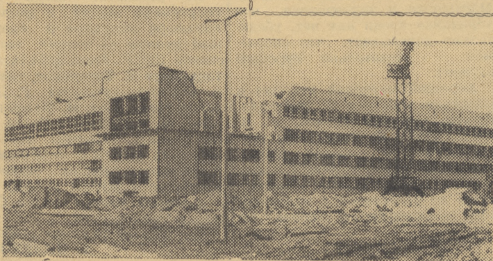
Новые светлые и просторные здания институтского городка строятся для нас на Каширском шоссе. По указанию вышестоящих организаций первая очередь комплекса зданий МИФИ будет сдана в эксплуатацию к 1 сентября 1962 года. А так выглядит главный корпус 1 сентября 1961 года.
