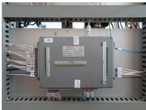
Рисунок 14 – Программируемый логический контролер с платой для подключения датчиков и исполнительных устройств
