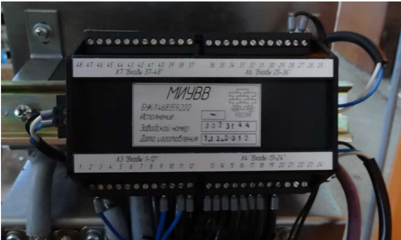
Рисунок 15 – Модуль интеллектуального удаленного ввода-вывода
