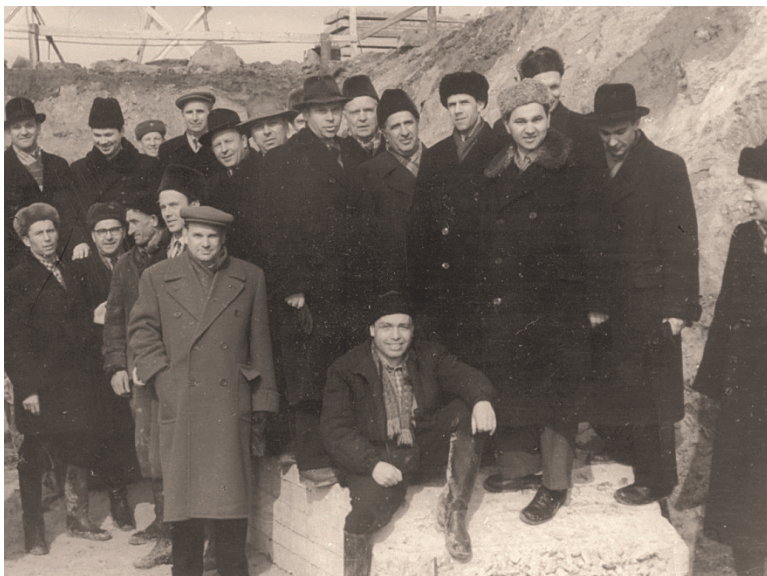
На закладке фундамента МИФИ на Каширском шоссе
