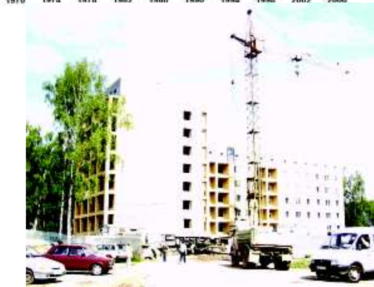
Заканчивается строительство одного из домов программы «Доступное жилье».
