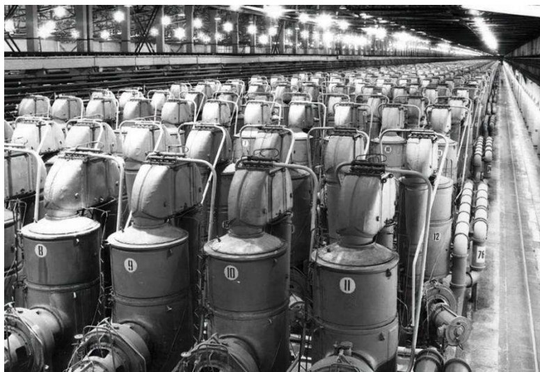
Рис. 5.3. Каскад газодиффузионных ступеней разделения изотопов урана
