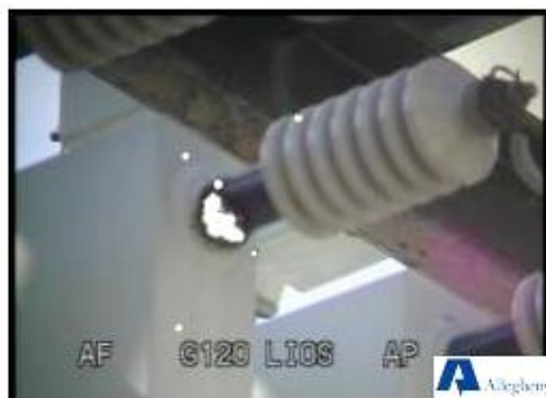
Рисунок 1 – Корона в месте соединения втулки и конденсатора
