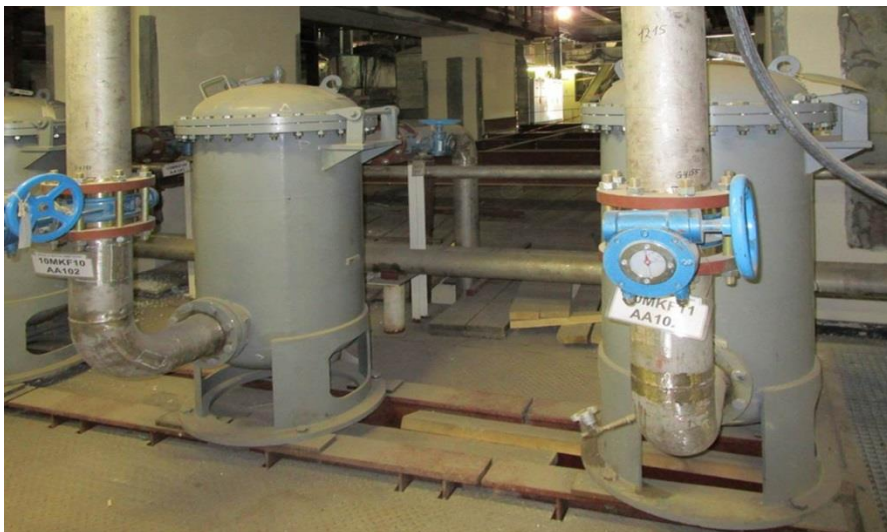
Фильтры магнитно-механические
