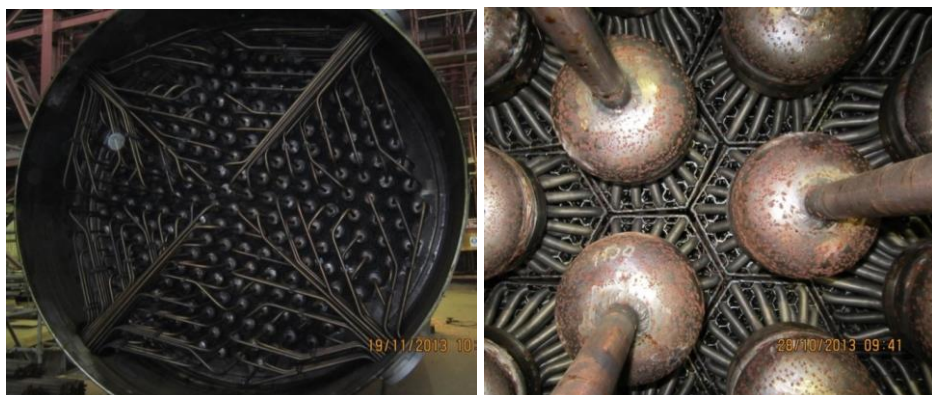
Кассеты пароперегревателя СПП
