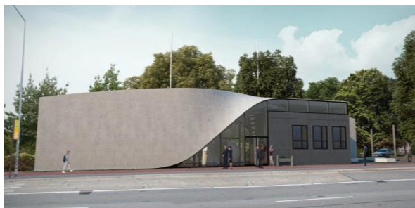
Рисунок 3 – Куб – первое в мире здание из углеродистого бетона
