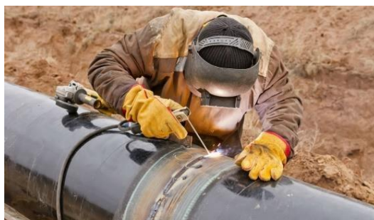
Рисунки 1 РД – ручная дуговая сварка покрытым электродами
